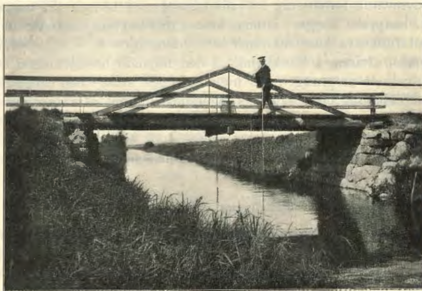
Fig. 34. Mätning med flygel 37 från bro vid Gräveby i Tysslingens utlopp (61—135).
