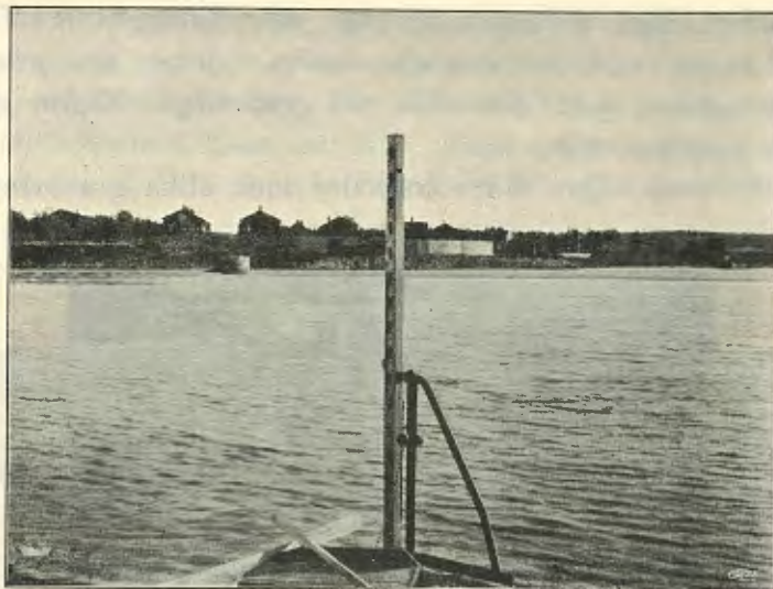
Fig. 7. Äldre träpegel å järnställning vid Månsbo i Dalälven (53—123), ensidig indelning i m, dm och 1- cm med dm-siffror.
