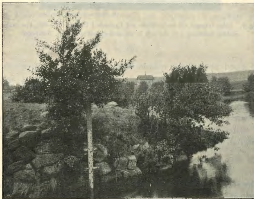
Fig. 8. Äldre träpegel vid gammalt dammlandfäste vid Laholm i Lagan (98—222), 2,5 m längd, ensidig indelning i dm och 1- cm med m- och dm-siffror. Nedtill H-B-skala.
