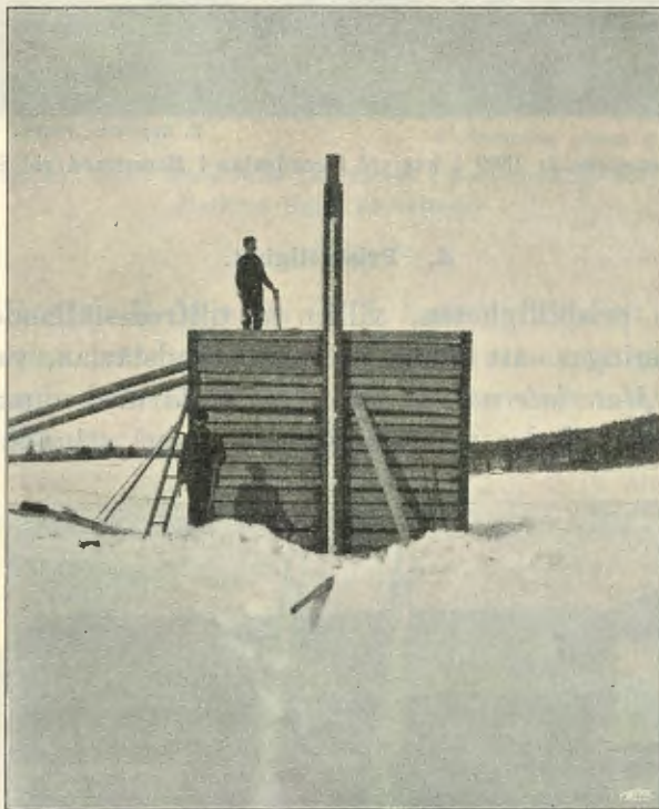
Fig. 20. 6- m H-B-pegel nedströms stenkista under uppförande vid Pajerim i Lilla Luleälv (9—31).
