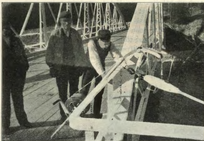
Fig. 57. Mätning med torpedflygel 36 från landsvägsbro i Indalsälven vid Hammarforsen (40—558).
