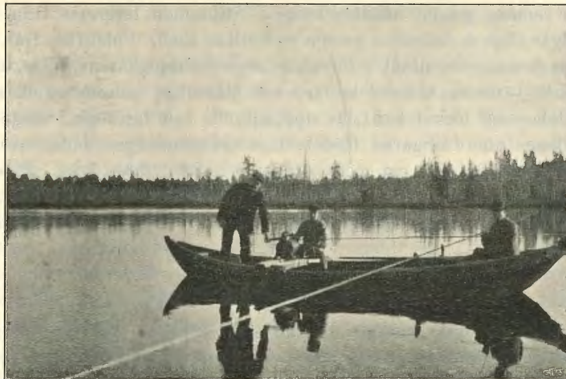
Fig. 48. Mätning med flygel 31 från båt i Pärälven vid Puornak (9—29).
